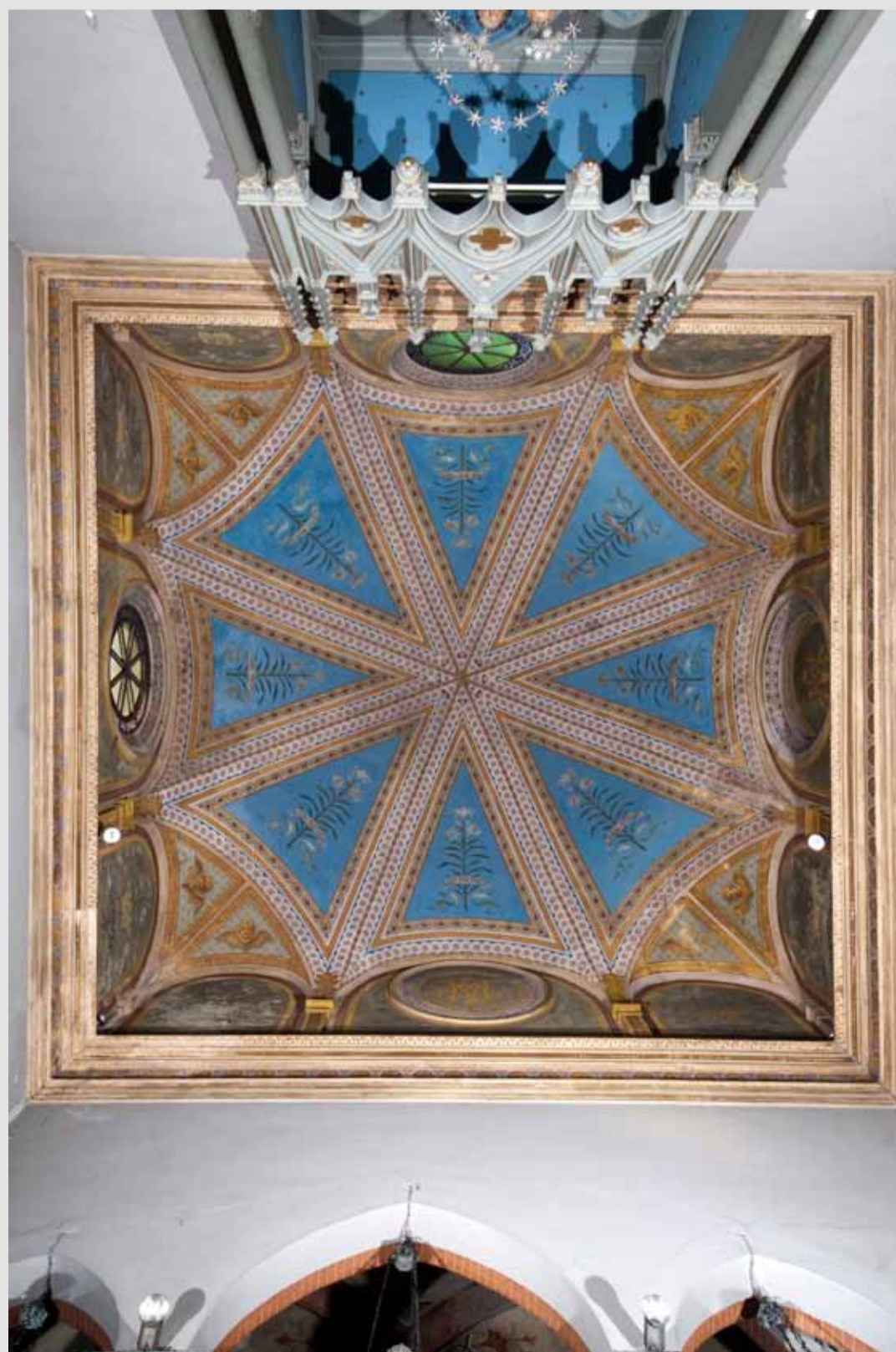
Volta attuale della cappella con decorazioni del 1902-03
